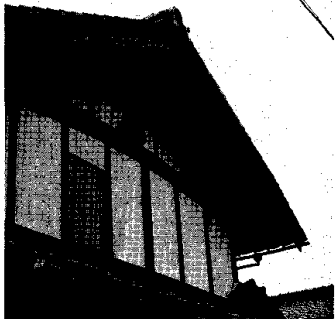
▼両端が妻側に突き出した地棟は湖北特有の工法。
