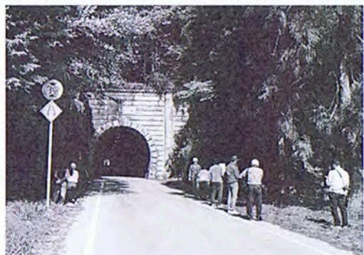
▲取材班、谷坂隧道に到着
