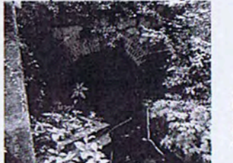
⑦ 姉川から取り込んだ伏流水が流れ出てくる底樋の口（31頁参照）
