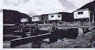
③ 国営。堤高2.0m、堤長52.1m。越流型鋼製格構造ローラーゲートという形式。昭和59年3月に造られた
