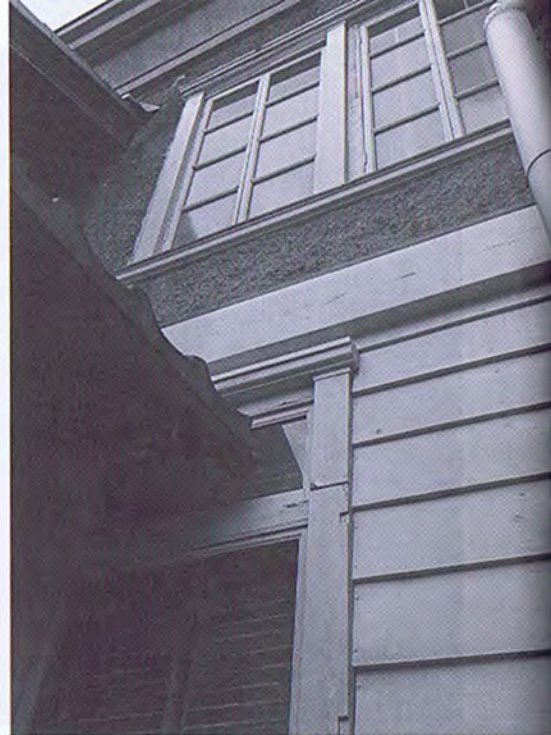
▲建物裏側の一部で、元の下見板張りが確認できる
